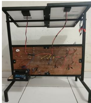
Gambar 4: Hasil Pemasangan Instalasi Listrik Seluruh Sistem (Tampak Belakang)
